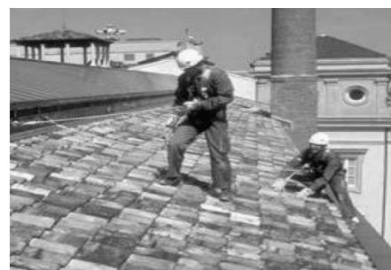
Figura 2-6. Sobrecarga Mantenimiento (L r )
