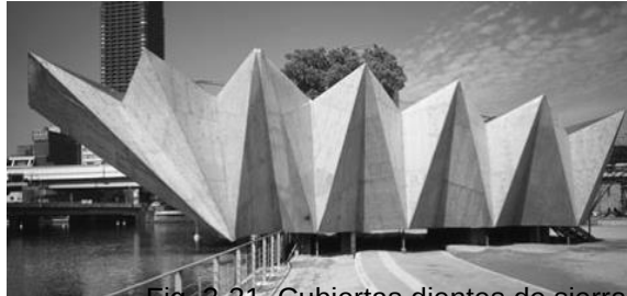
Fig. 2-21. Cubiertas dientes de sierra
