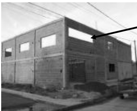
Figura 1.36-Incorrecta disposición de encadenados rodeando una abertura. 5
