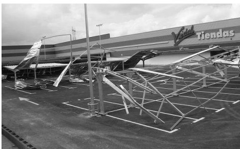
Fig. 2-36. Daños ocasionados por el viento en estructuras livianas
