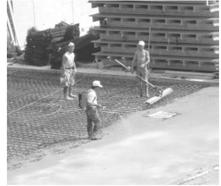
Fig. 7-8. Bombeado del Hormigón Elaborado
