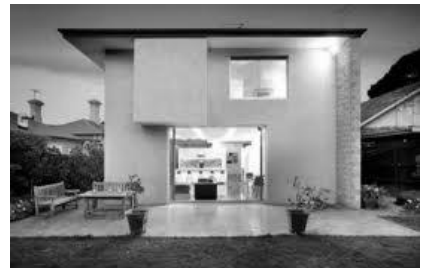
Fig. 2-41. Ej. Edificio parcialmente cerrado
