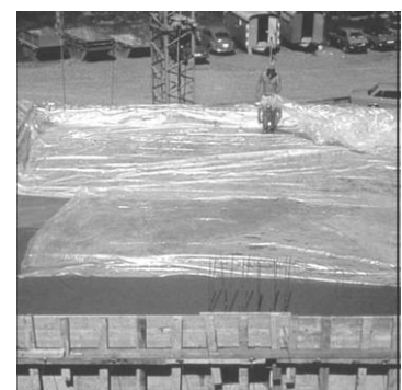
Fig. 7-7. Curado del Hormigón
