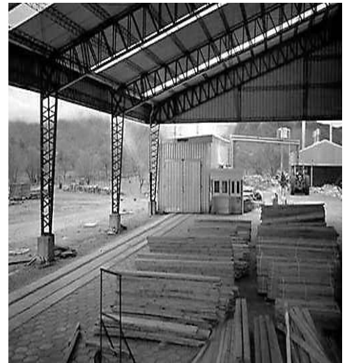
Fig. 5-11. Acopio de madera
