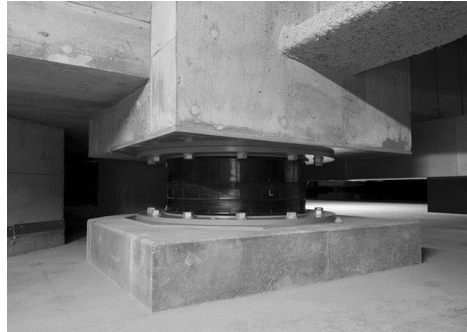
Apoyo de neopreno (Deslizante)
