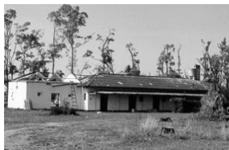
Fig. 2-36. Daños ocasionados por el viento en estructuras livianas
