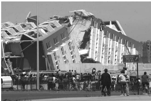
Fig 2-33. Sismo del 27 /02/10 CHILE - 8,8 en escala Richter 512 muertos, solo 8 por terremoto, el resto por el maremoto. En la foto uno de los pocos edificios colapsados
