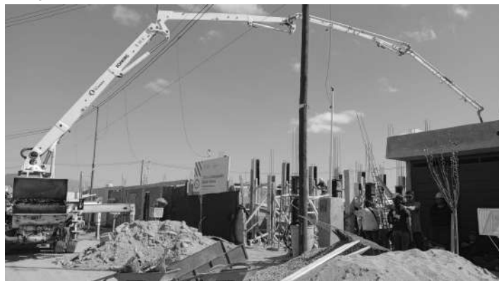
Imagen (23). Llenado de columnas con maquinaria especializada.
