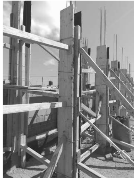
Imagen (22). Encofrado de Madera realizado in situ.
