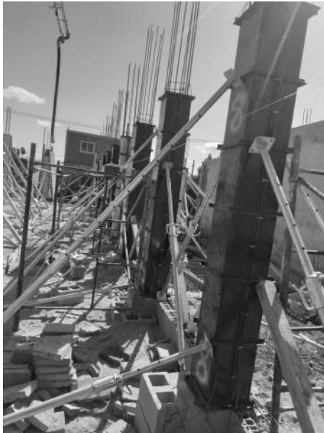
Imagen (21). Encofrado diseñado por productores de Herrería en el Centro del M.T.E.
