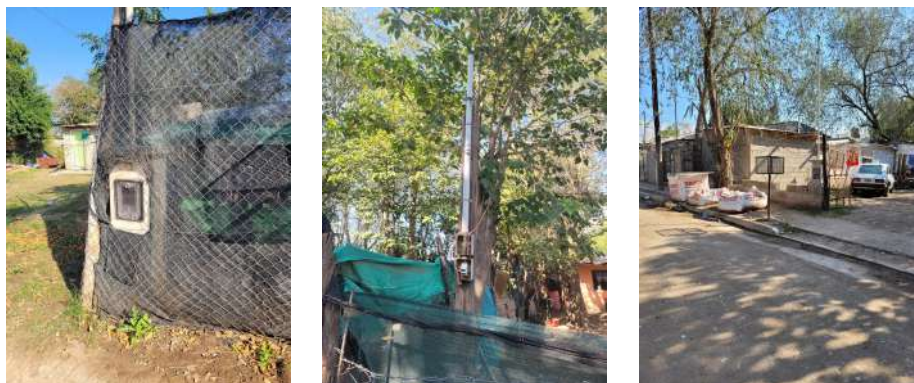
Imagen 13, 14 y 15 - Situación general de las conexiones del barrio.
