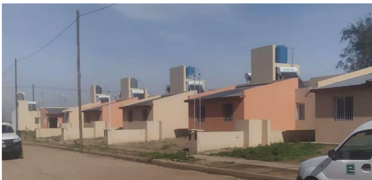
Foto 25 - Situación general de las condiciones de las viviendas.
