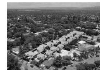
VISTA AÉREA DEL CONJUNTO. Fuente: TAIANA PROPIEDADES
