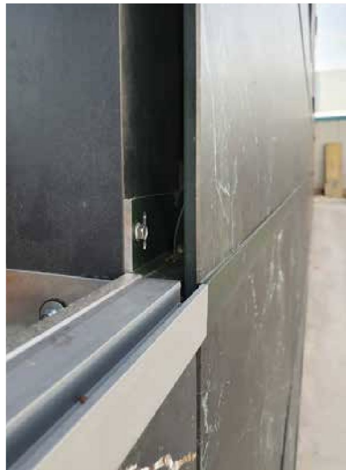
Fachada ventilada Rocalux Apoyo continuo vista lateral
