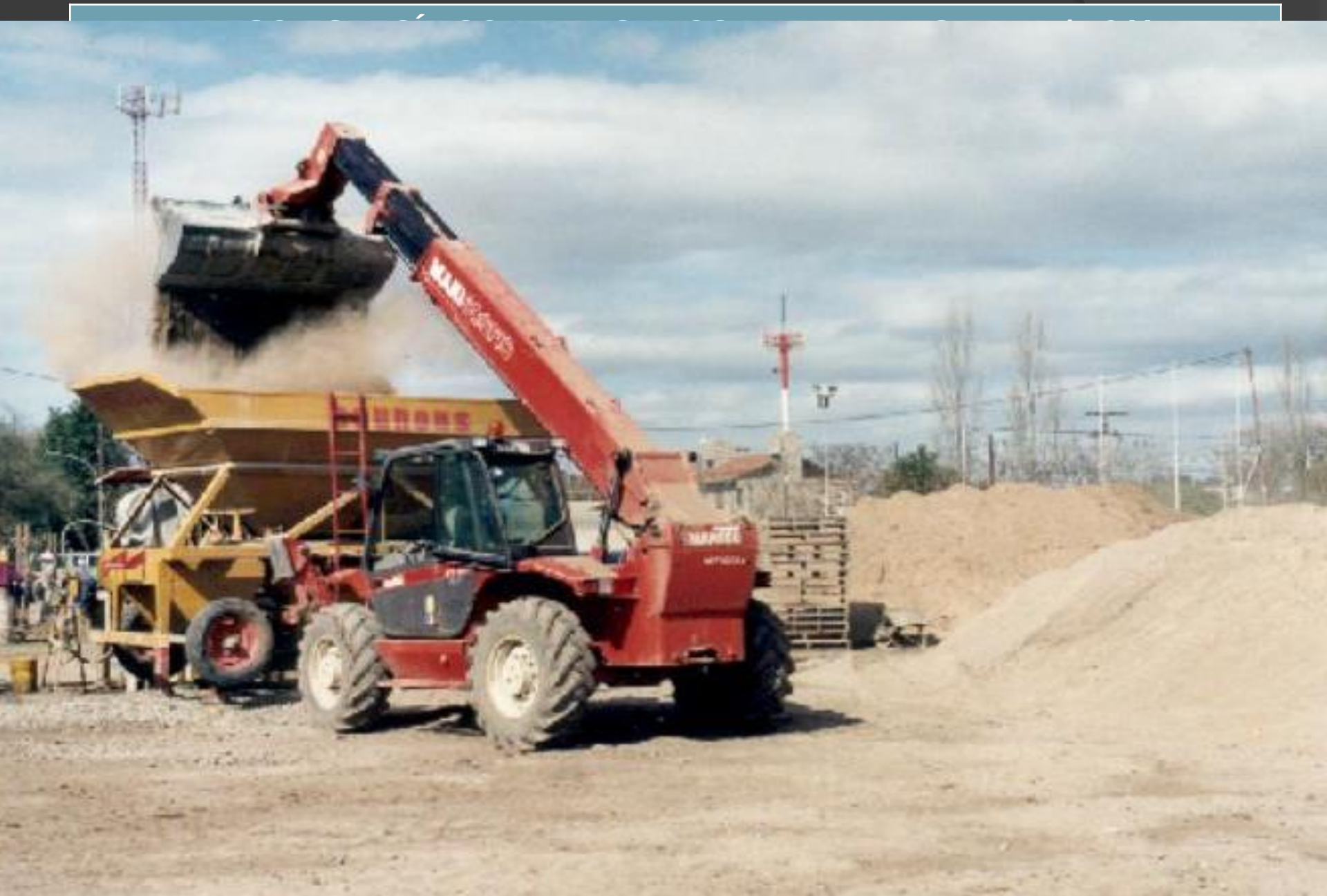
Cargando áridos en tolva
