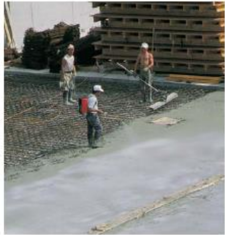
FIG. 2.5.3 Regado de un compuesto formador de membrana sobre una calle de hormigón.
