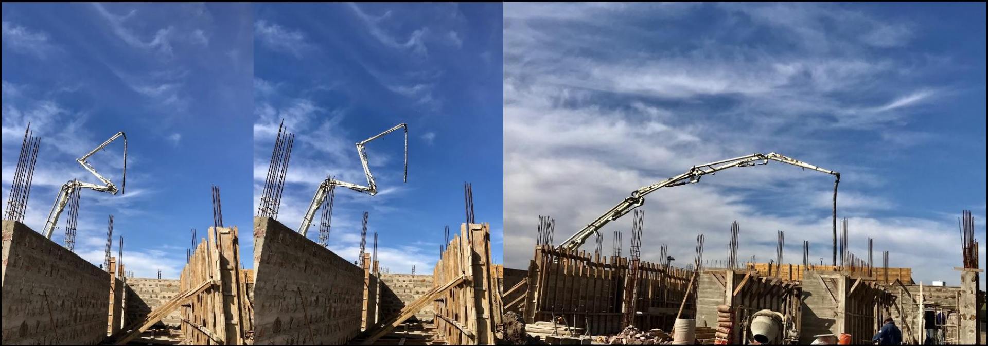
vertido de hormigon - bomba
