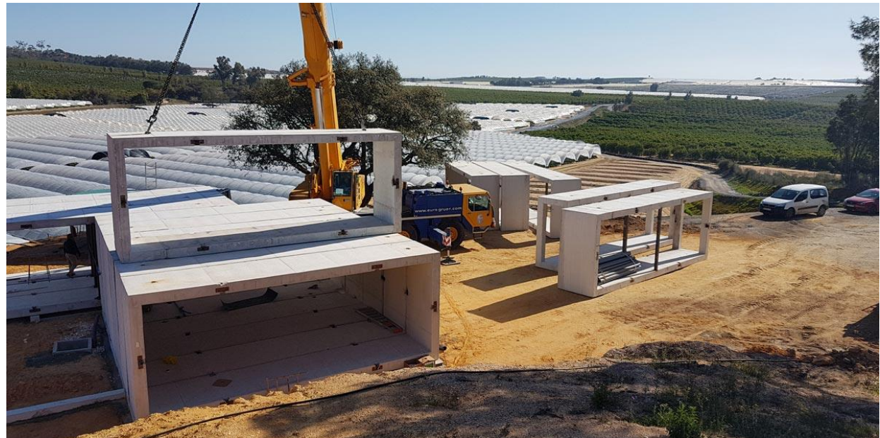
componentes de hormigón
