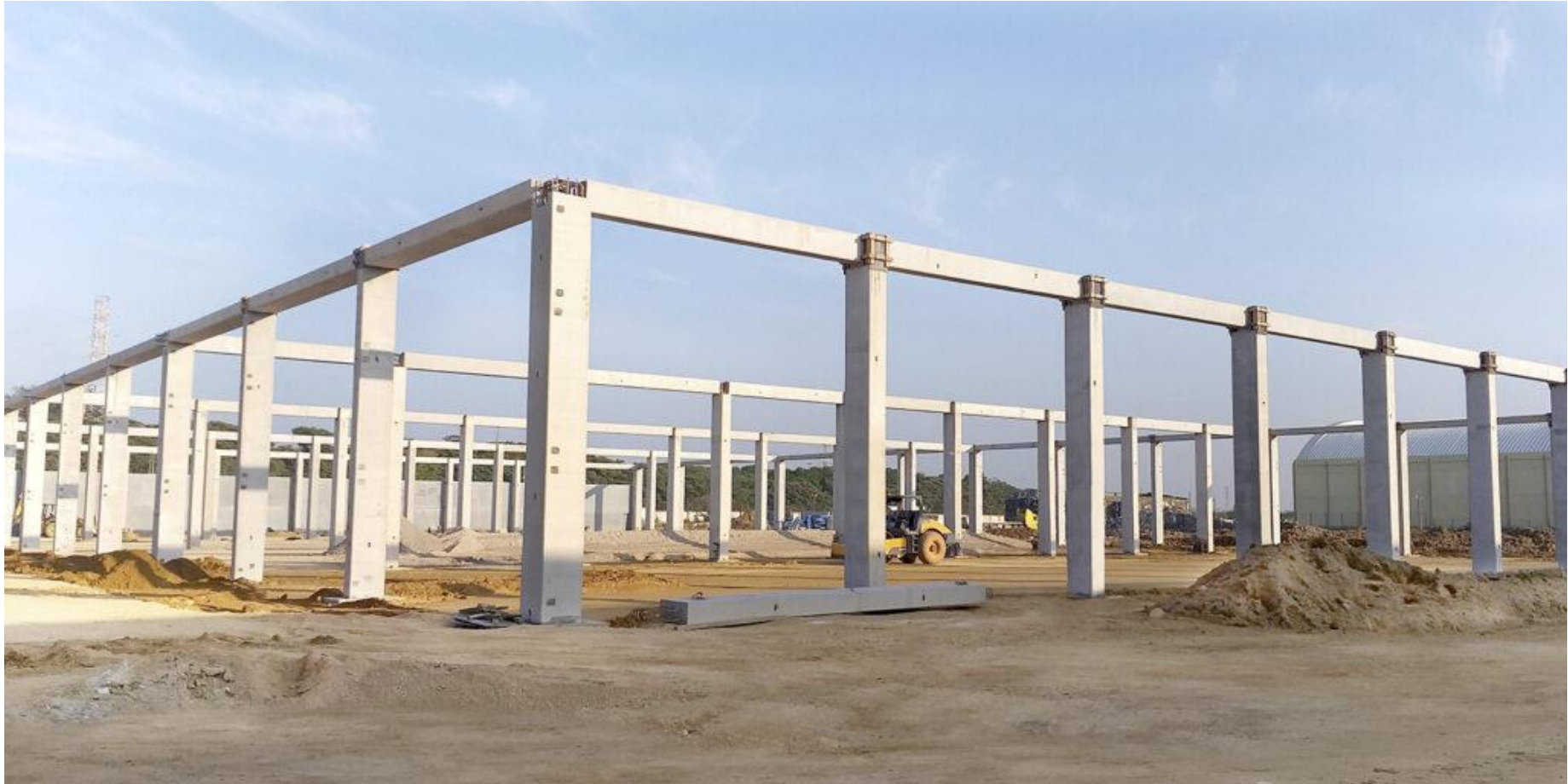
componentes de hormigón
