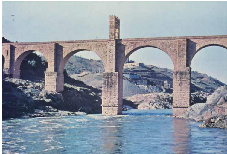
Puente acueducto en Alcántara
