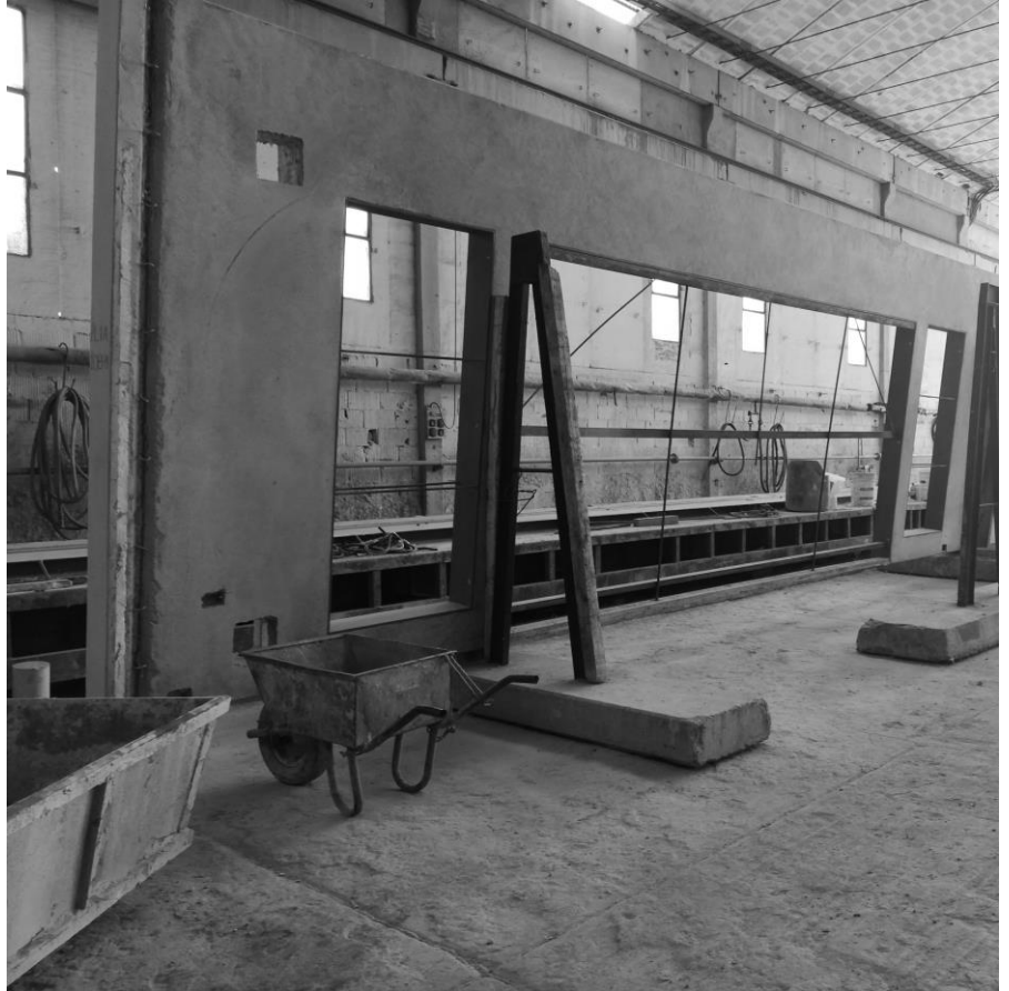
Paneles con vanos para puertas ventanas y ventanas, se incluyen también cajas de luz y el pase para regillas de vinculación. Imagen tomada en planta Astori.
