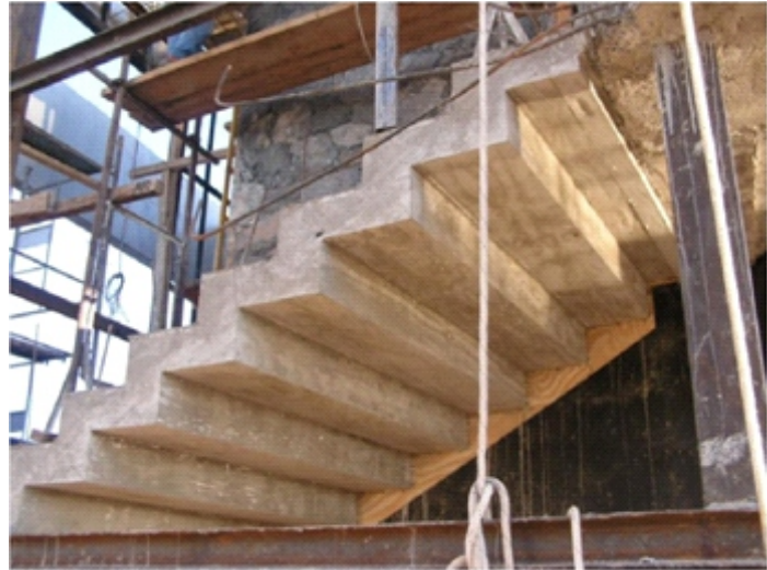
Zanca a cremallera de H^\circ A^\circ a la vista. Cada escalón requiere de una armadura como si fuera un voladizo respecto al anterior.
