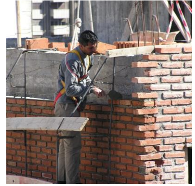
Trabajo de revestimiento de edificios con ladrillo a la vista y bloque cerámico al interior (doble muro)
