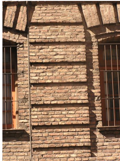
Construcción Salesiana en Córdoba con muros de 50/60cm de espesor.
