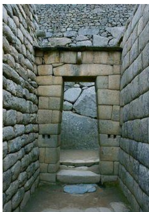
Peru: Construcción incaica Ollaytantambo. Piedra tallada sin juntas.
