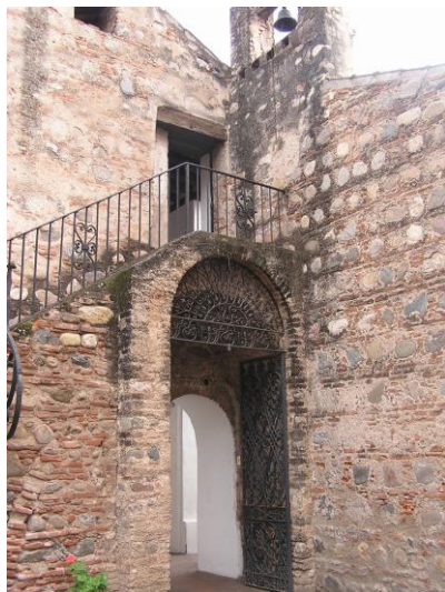
Construcción colonial en Córdoba, alternando ladrillo y calicanto. Muros de 40/50cm de espesor.
