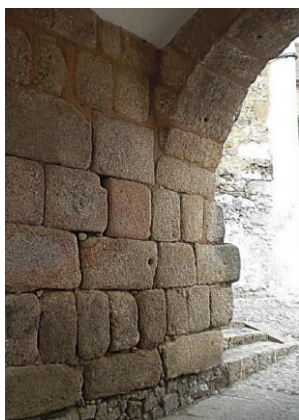
Calle de Italia. Piedra tallada con juntas.
