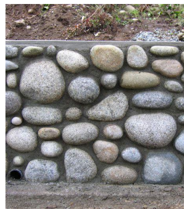
Canto rodado con juntas: calicanto.
