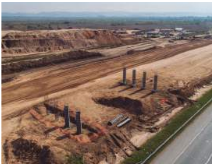
Construcción de columnas de los puentes que conformarán el distribuidor de avenida Santa Ana.
