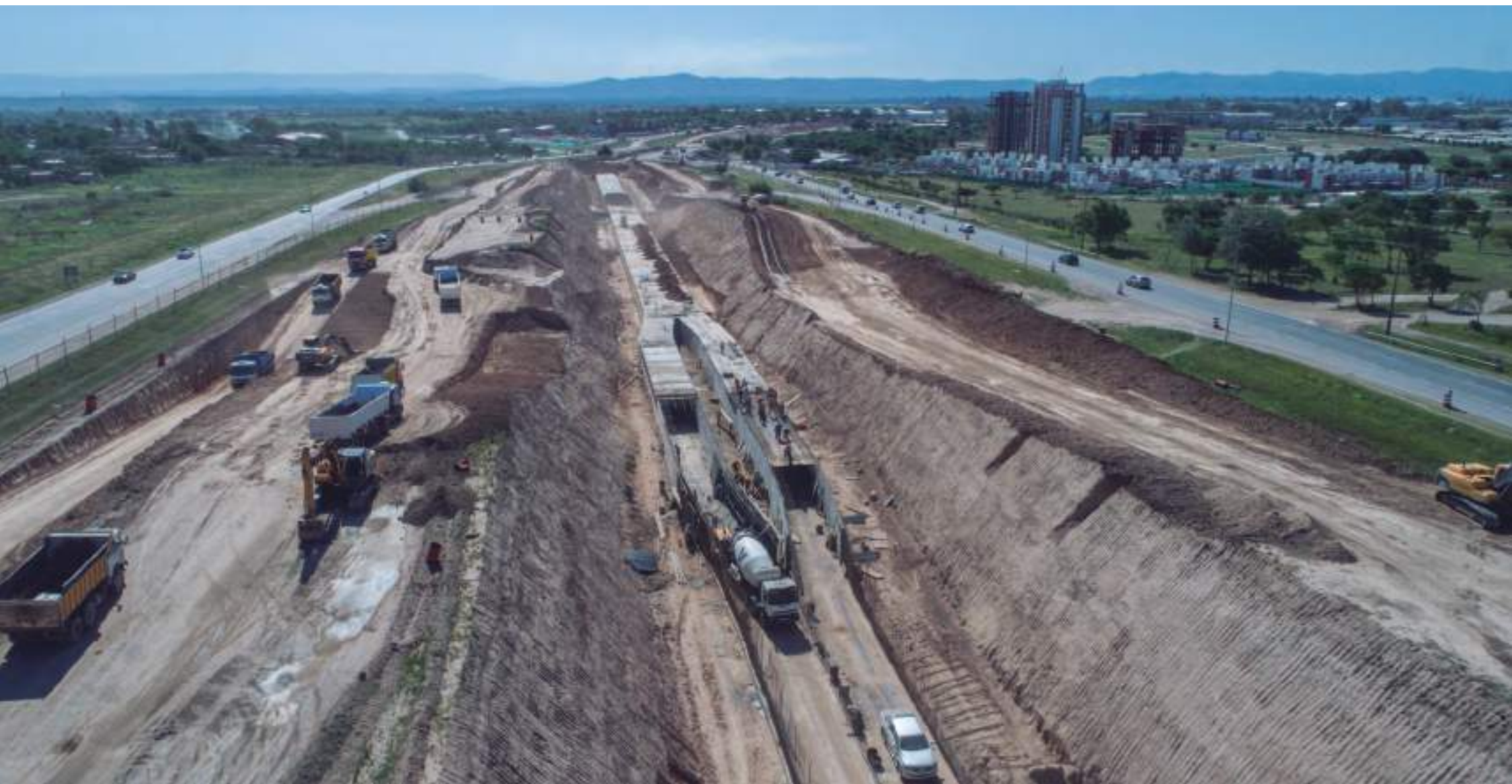
Vista hacia el Oeste del gran conducto de desagüe que vierte desde el Este hacia el arroyo La Cañada. Su gran envergadura se puede verificar viendo la presencia de un camión volcador dentro de uno de los dos conductos que luego se unifican en el tramo final.
