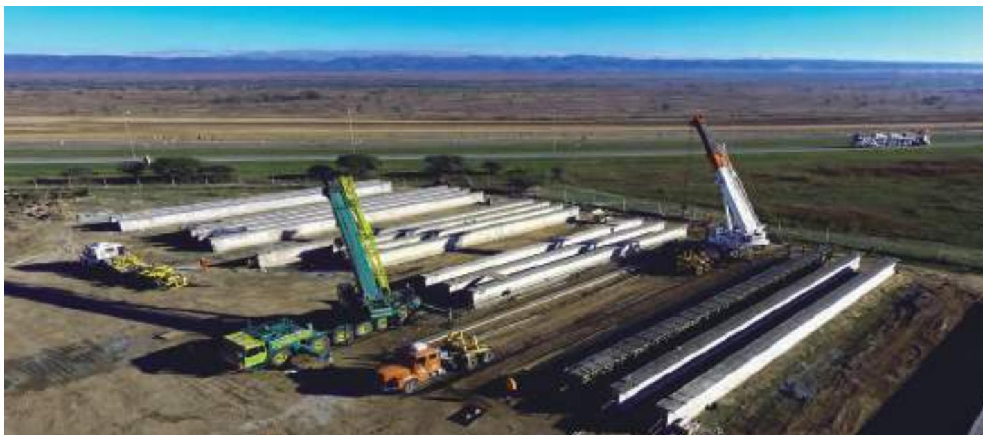
Detalle del obrador con el acopio de vigas de la estructura de los puentes.
