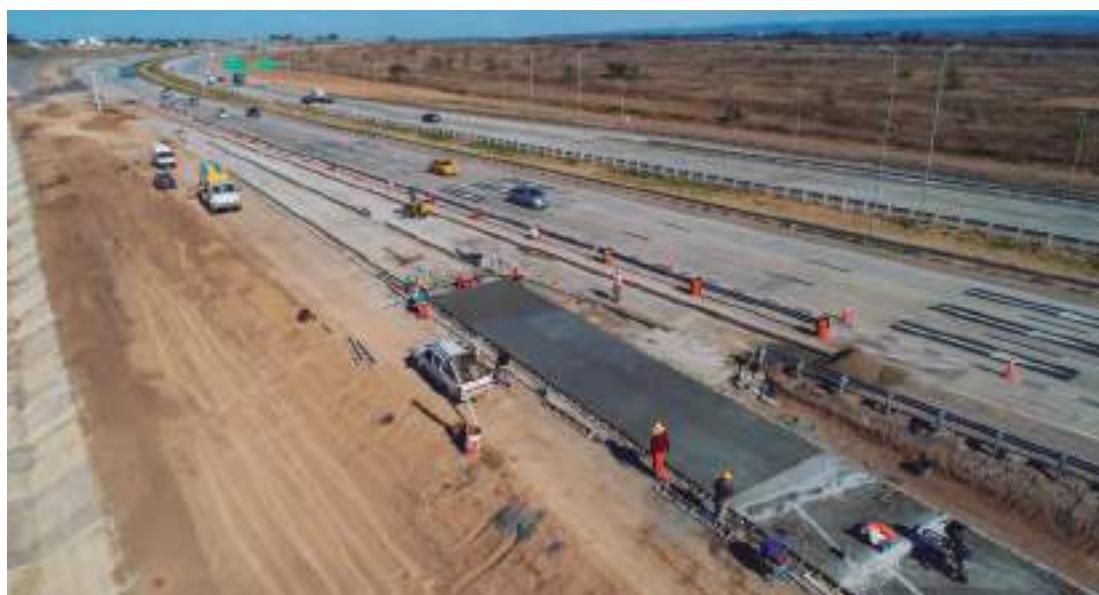
Avance de obra del distribuidor de avenida Santa Ana. La importancia de esta avenida radica en que, junto a su continuidad con boulevard Illia y avenida Sabattini posibilita la conexión O-SE y cruza la ciudad de manera completa.
