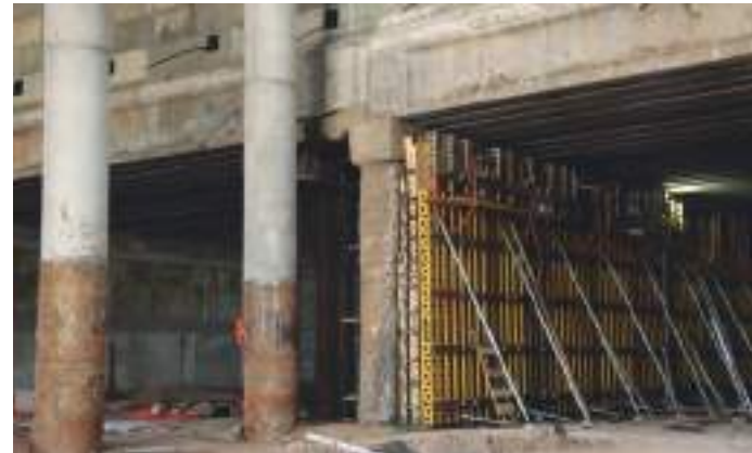
Izquierda: Trabajos de excavación y consolidación de la estructura existente bajo el puente Martí.
