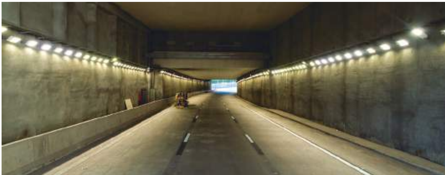
Prueba de iluminación y finalización de carpeta sobre calzada del túnel.
