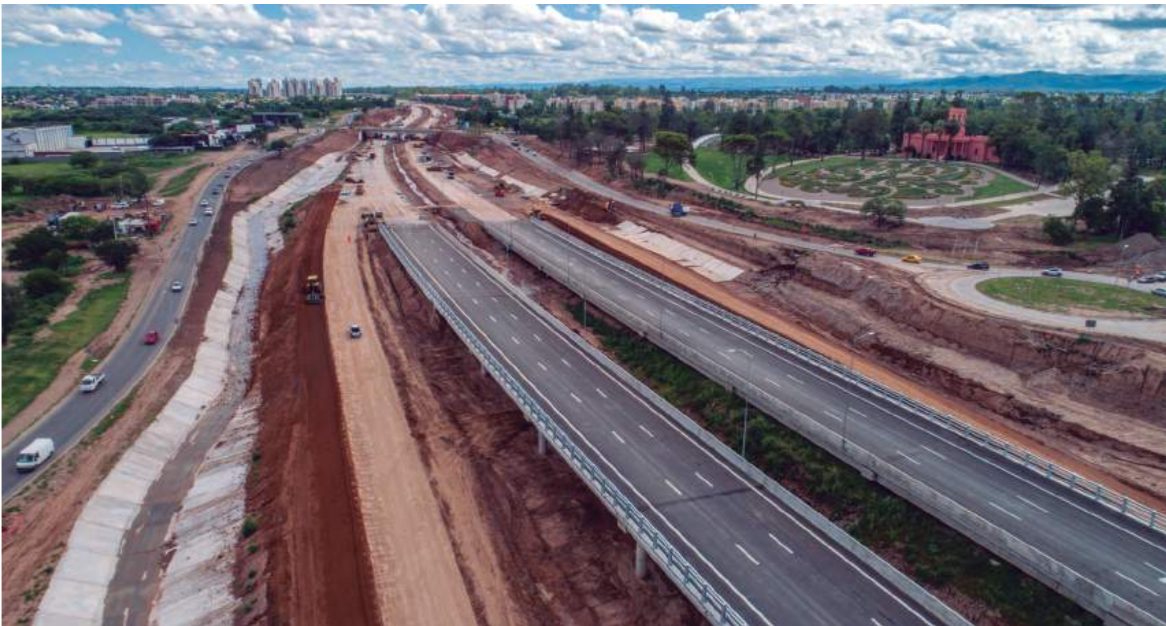
Vista del final del viaducto donde se aprecian los grandes canales de desagüe a cielo abierto.
