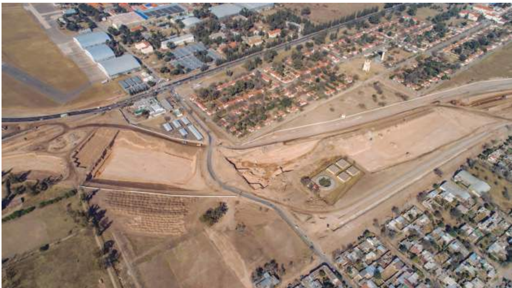
Vista particular del sector de paso por terrenos de la Fuerza Aérea durante las tareas de excavación para generar el tramo en trinchera hacia el Sur. A la derecha de la imagen se ve la gran cisterna existente que se debió reconstruir en una nueva ubicación.
