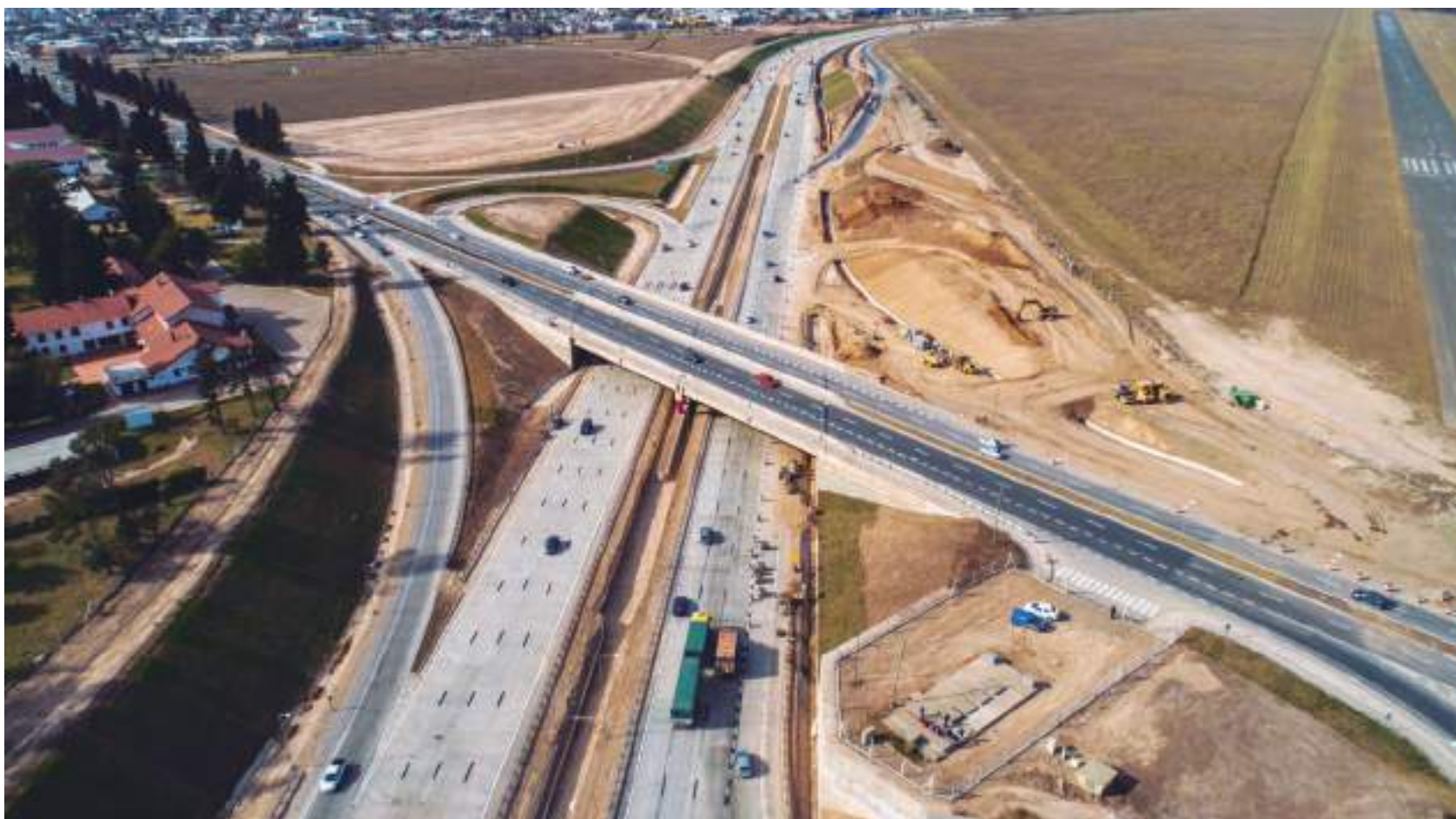
El cruce bajo nivel de Avenida Fuerza Aérea con su distribuidor compuesto por ramales de giro y rulos que permiten la accesibilidad a los barrios e instituciones del sector, como el Instituto Universitario Aeronáutico.
