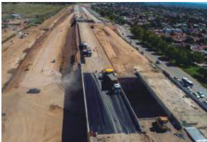
Construcción de losas de hormigón y carpeta asfáltica de colectoras.
