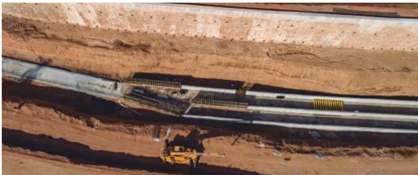
Detalle de encofrado y hormigonado de conductos pluviales.
