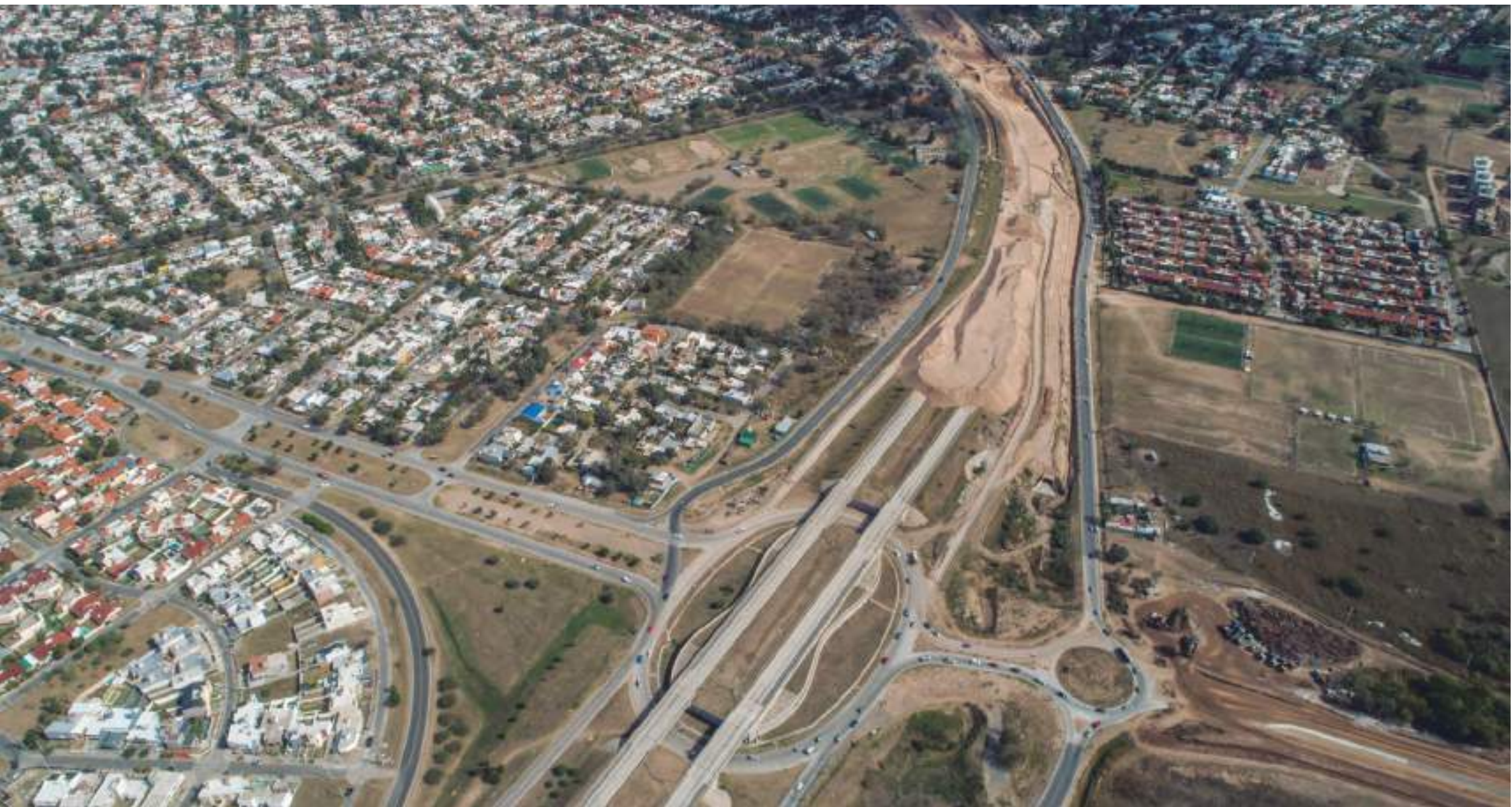
Vista aérea desde el distribuidor existente sobre avenida Spilimbergo. Sobre la derecha se ve la continuidad de la avenida hacia Los Boulevares, creando así un nuevo acceso hacia el aeropuerto.
