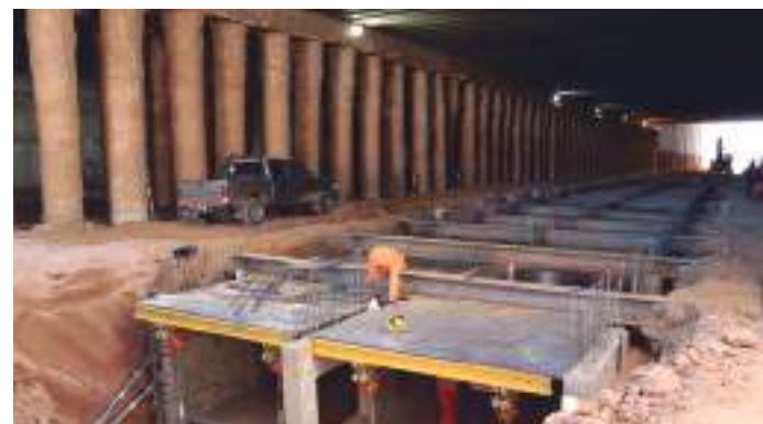
Izquierda: Trabajos sobre los anclajes de los muros colados.
