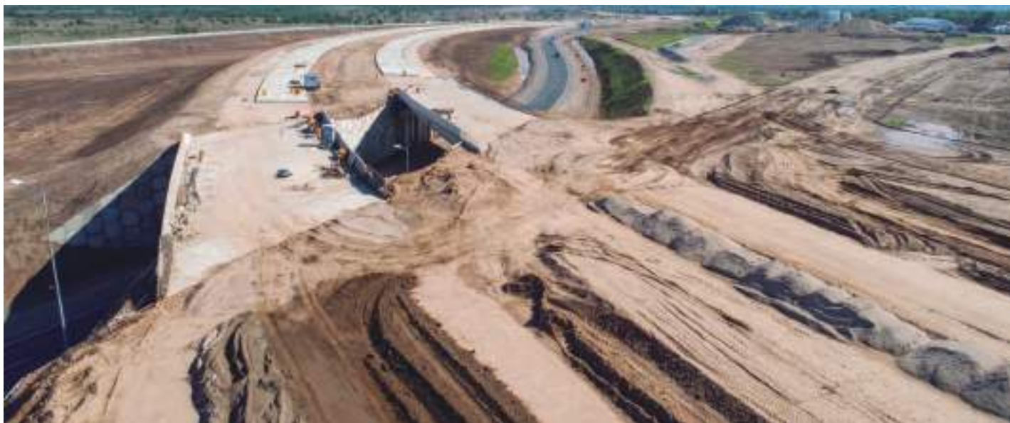
Tareas de consolidación de suelos a nivel.
