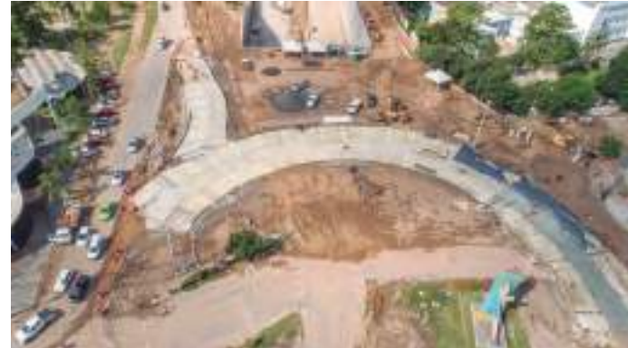
Proceso constructivo de la nueva rotonda ampliada de la Mujer Urbana.
