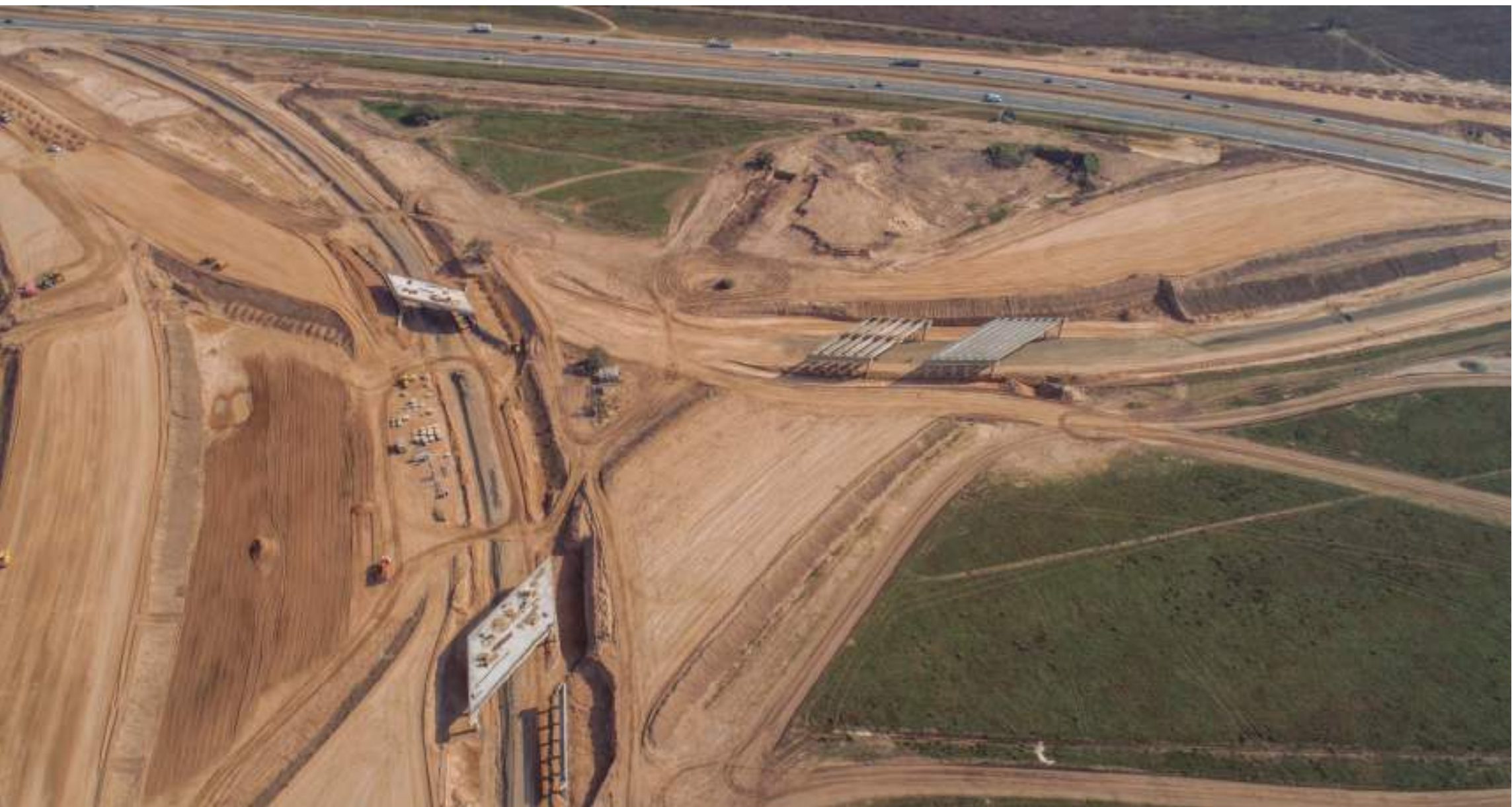
Distintos momentos en la construcción de la estructura de los puentes de conexión.
