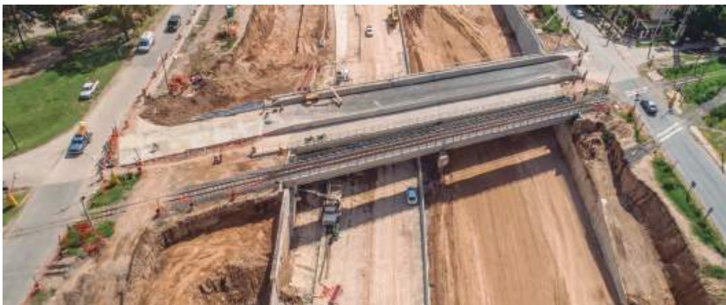
Detalle de nuevos puentes ferroviarios por el que circula el Tren de las Sierras y el puente vial que da continuidad a la Avenida Cardeñosa.
