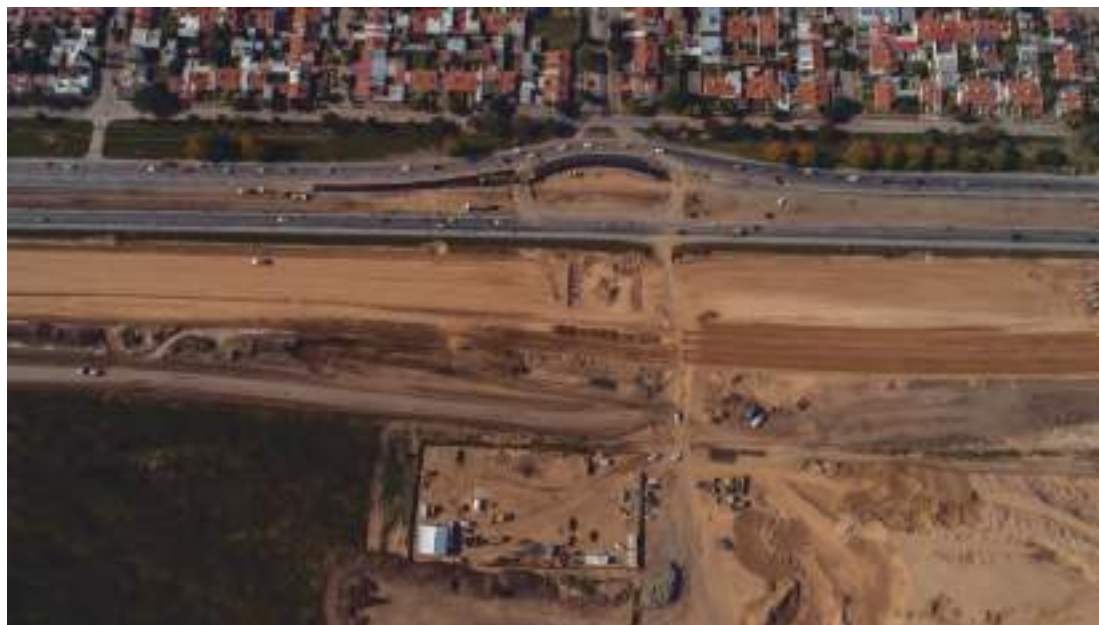
Vista aérea del obrador ubicado a la altura del nudo de avenida Santa Ana.
