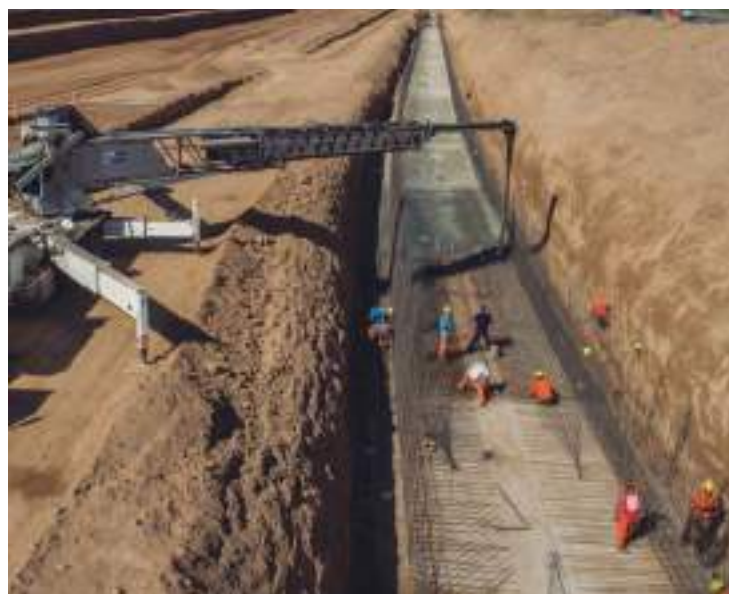
Armado de hierros y hormigonado de conductos de desagüe lateral.
