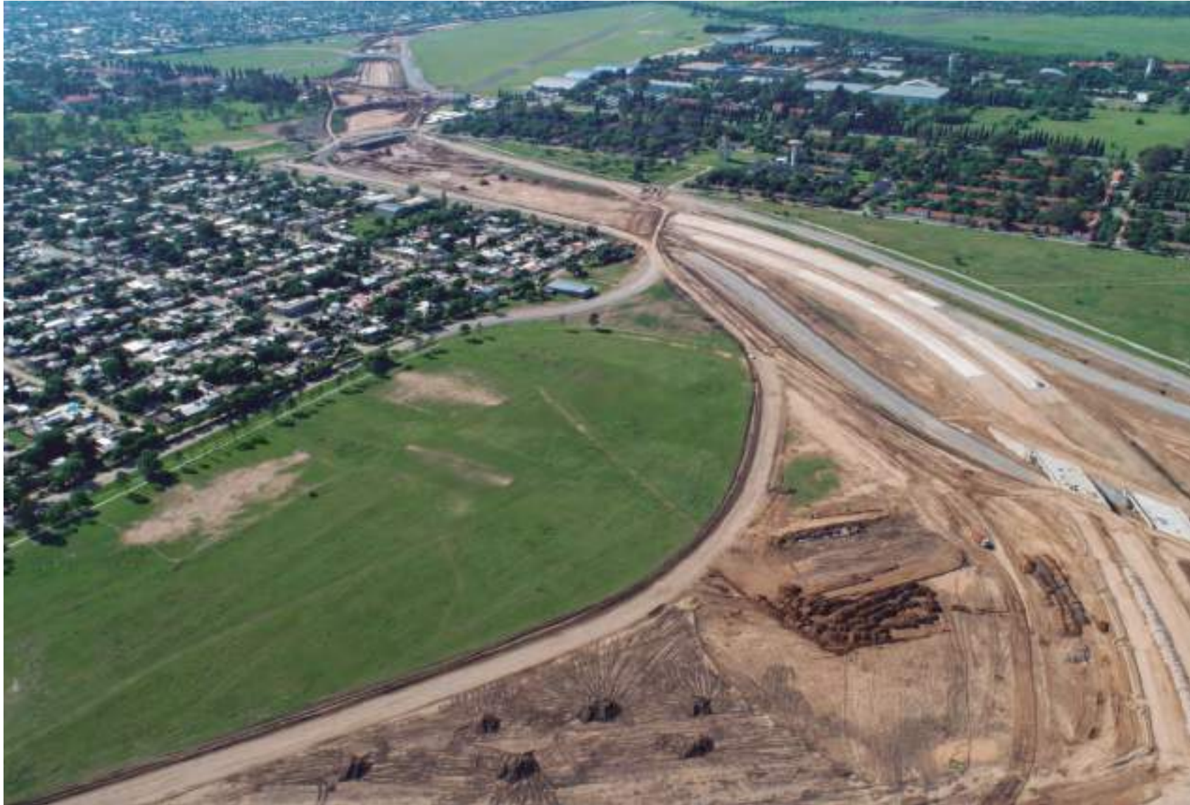
Vista general del paso de la avenida Circunvalación por terrenos de la Fuerza aérea. En primer plano se observa la avenida Fuerza Aérea ya cortada y la derivación hacia el sur del tráfico corriente por una calzada construida ad hoc que funcionó solo durante el tiempo de obra. A la derecha se ve la pista de aterrizaje de FAdA.
