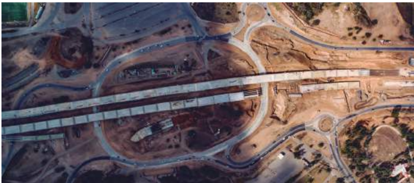
Vista aérea del sector donde se aprecia el avance en la construcción del paquete estructural del viaducto y el trazado de la gran rotonda de distribución.
