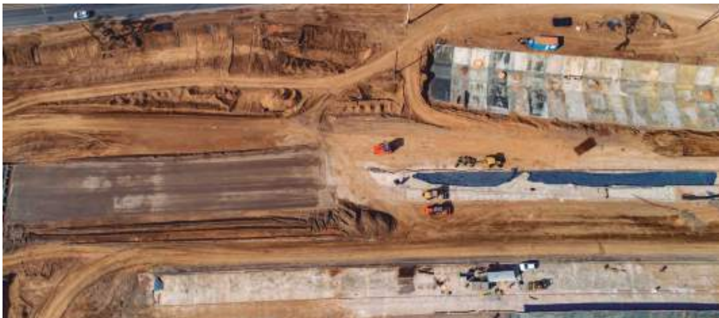
Proceso constructivo: canales abiertos de desagüe y movimiento de tierra.
