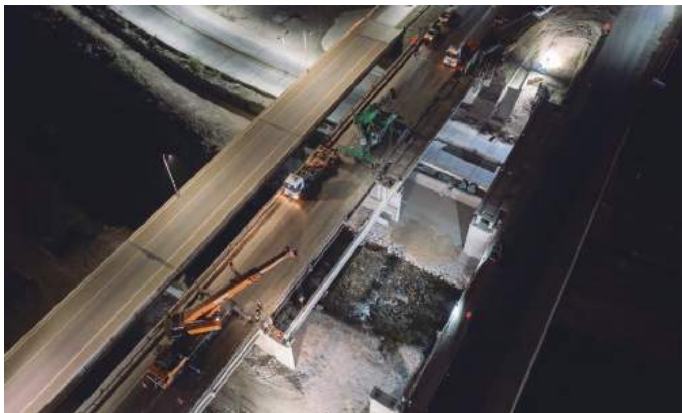
Detalle de la obra en el tramo y puentes de la ruta 9 sur.
