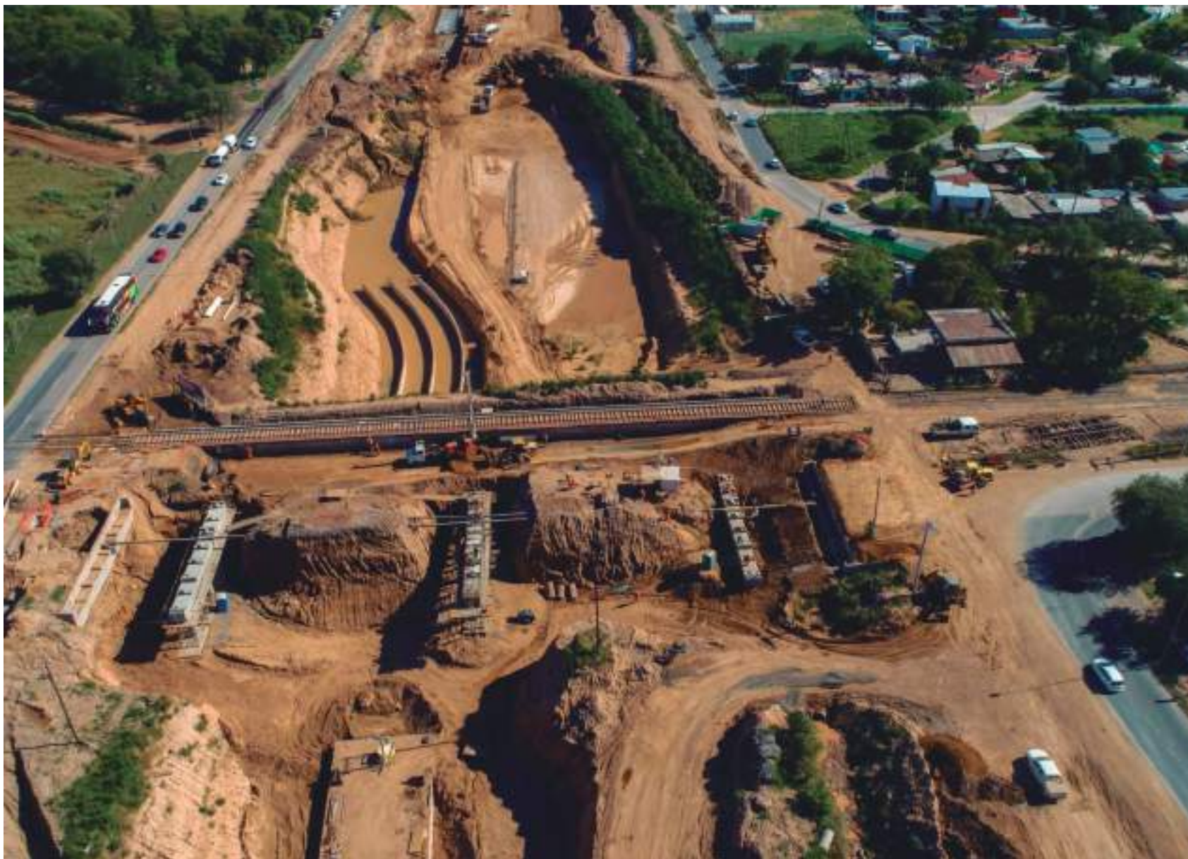
Inicio de las excavaciones para desagües pluviales y para la realización del puente que dará continuidad al ramal ferroviario.
