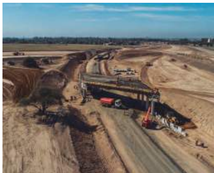
Detalle de la plataforma de trabajo empleada para el llenado de las fundaciones y columnas de soporte de uno de los puentes y tareas de hormigonado de otro de los puentes.
