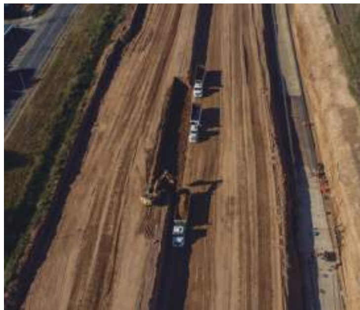
Trabajos de excavación y retiro de material para crear el paso en trinchera de la Avenida de Circunvalación.
