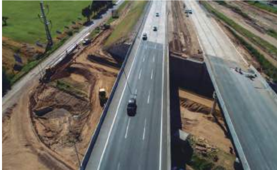
Dos momentos en la construcción de los puentes sobre la línea ferroviaria. Arriba, realización de carpeta asfáltica y abajo, uno de los puentes ya en funcionamiento mientras el otro a la espera de tratamiento final y pintura.
