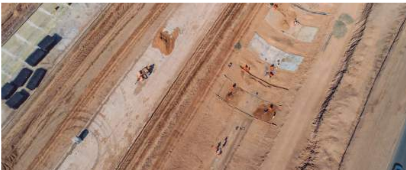
Proceso constructivo de los canales de desagüe y preparación de suelo para el trazado y construcción de las vías.
