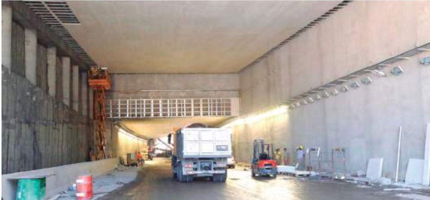
Construcción de cordones y defensas del túnel, finalización de los revestimientos y puesta a punto del sistema de iluminación.
