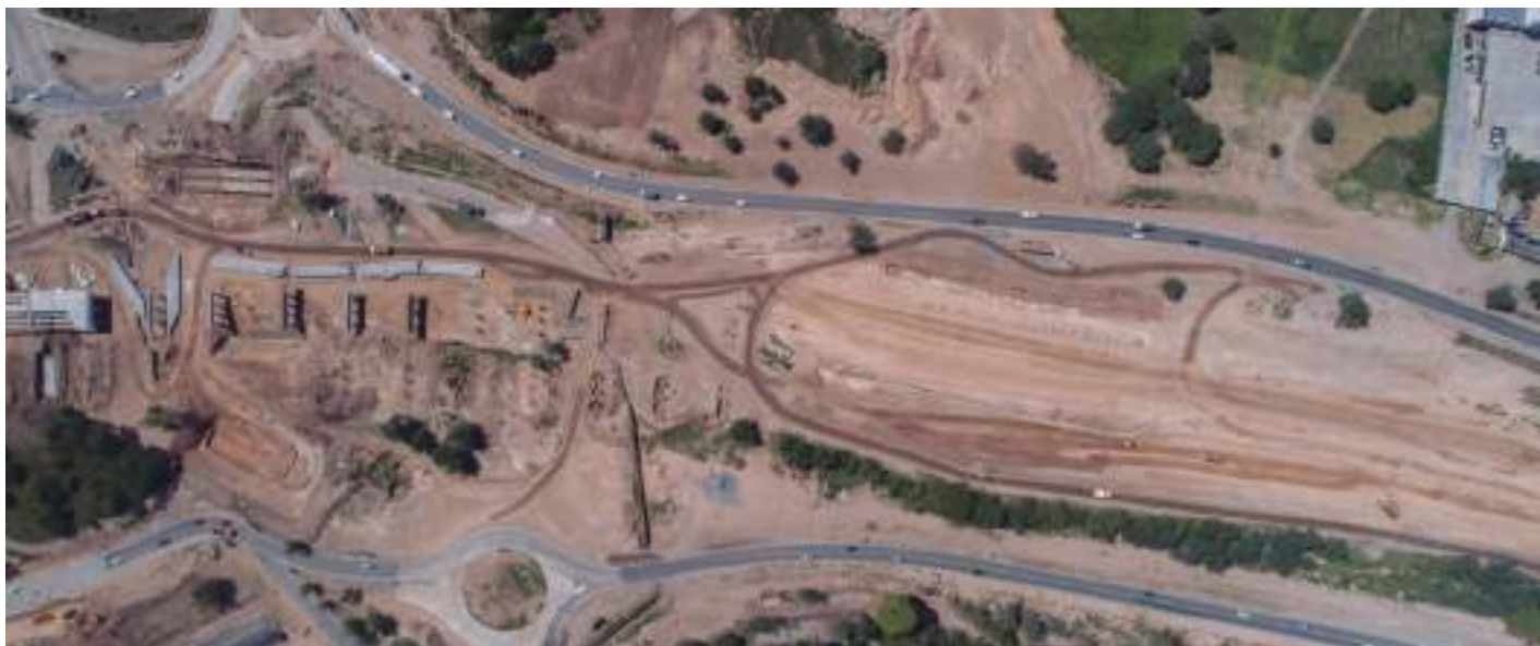
Vista aérea de la tarea de movimiento de suelos requerido para el trazado de las nuevas rotondas de conexión. A la izquierda se ve el avance del viaducto, los pórticos ya elevados y las losas sobre las que se desarrollará la vía sobre el suelo a la espera de su colocación.
