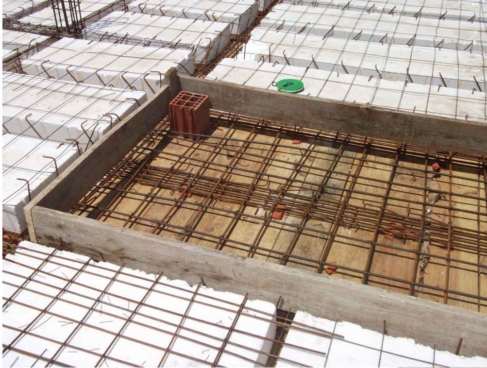
ENCOFRADO DE REBAJE DE LOSA Y LLENADO DE LOSA
