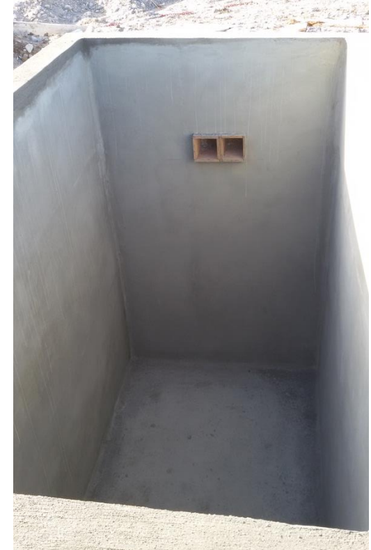
CÁMARA SÉPTICA DE GRAN VOLUMEN PARA RECIBIR IMPORTANTES CAUDALES CONCENTRADOS EN EL TIEMPO
