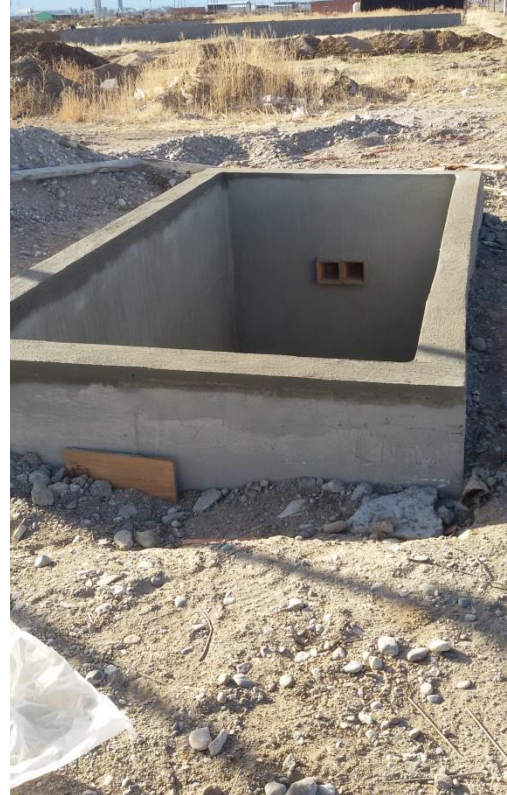
CÁMARA SÉPTICA DE GRAN VOLUMEN PARA RECIBIR IMPORTANTES CAUDALES CONCENTRADOS EN EL TIEMPO
