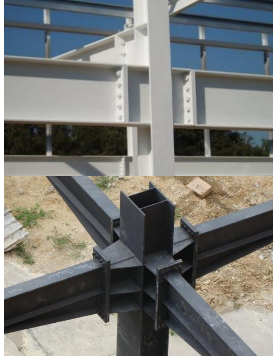
Soldaduras en taller y abulonados en obra
